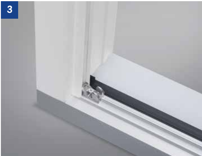
Kamsluiting fungeert als anti-uittilbeveiliging op de onderste hoek aan de greepkant van het vleugelement.
